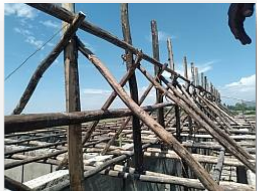
Bauarbeit in Zuway
